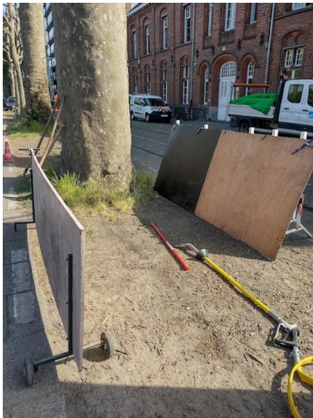
Figuur 3.18: Opstelling air spade Coupure Rechts.
