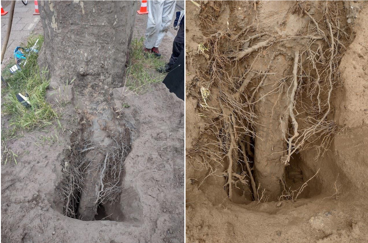
Figuur 4.7: Blootleggen van een paar boomwortels aan de rechterkant van de boom (ten aanzien van het fietspad).
